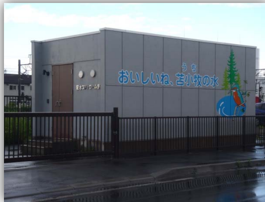
写真 2-4 配水コントロール施設
