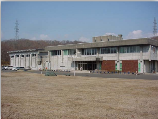
写真 2-2 錦多峰浄水場
