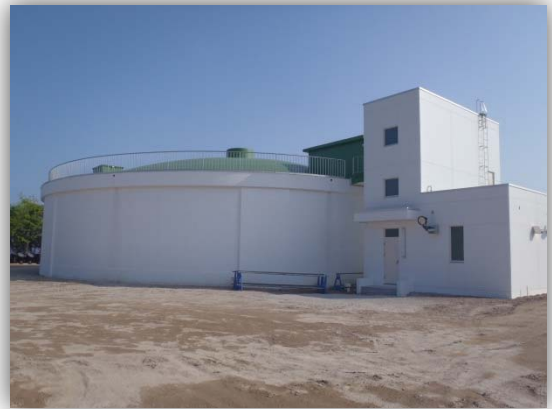
写真 2-3 錦多峰第3配水池
