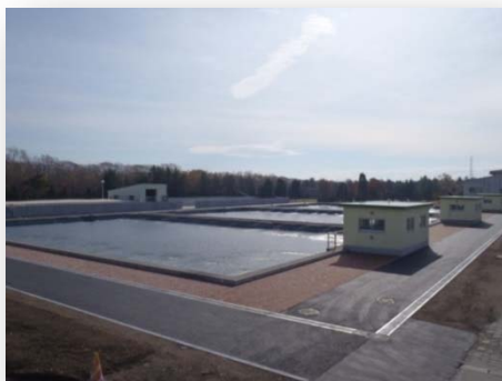
写真 2-1 耐震化が完了した 4~6 号緩速ろ過池
